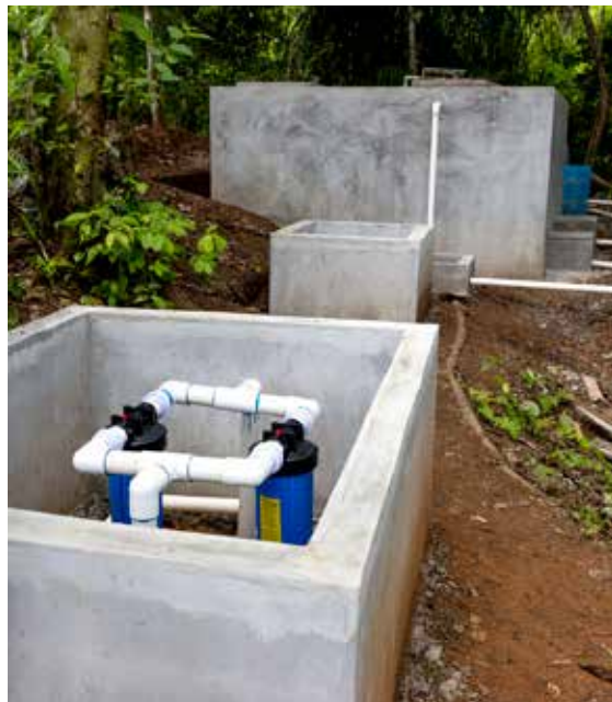
Sistema de acueducto en Quebrada Benítez.
